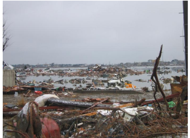
大津波により浸水した農地
